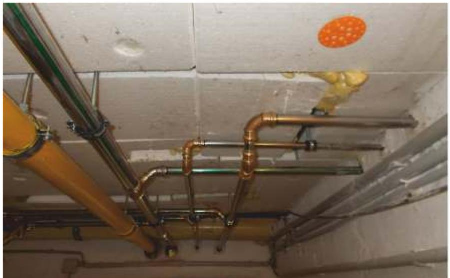
Zuerst erfolgt die Erneuerung der Kellerverteilung einschl. Strangventile (ca. 2 Tage je Hauseingang). Dabei werden die bestehenden Stränge provisorisch an die neue Verteilung angeschlossen.
